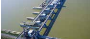
CONSTRUCCIÓN DE CENTRALES ELÉCTRICAS
